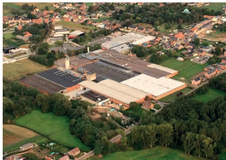
Door & Wooden frames factory in Bekkevoort (Belgium)
